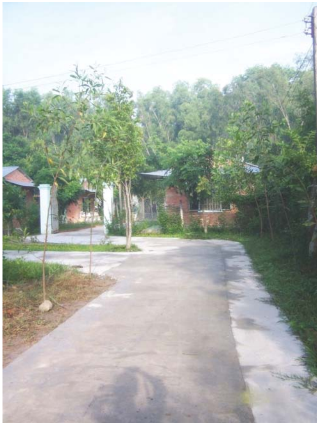
Hình 69. Đường vào khu phát triển
