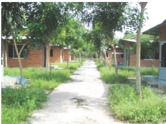
Hình 62. Khu thất trong tu viện
